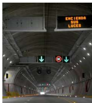
Acatúnel · Entronque Brisamar
